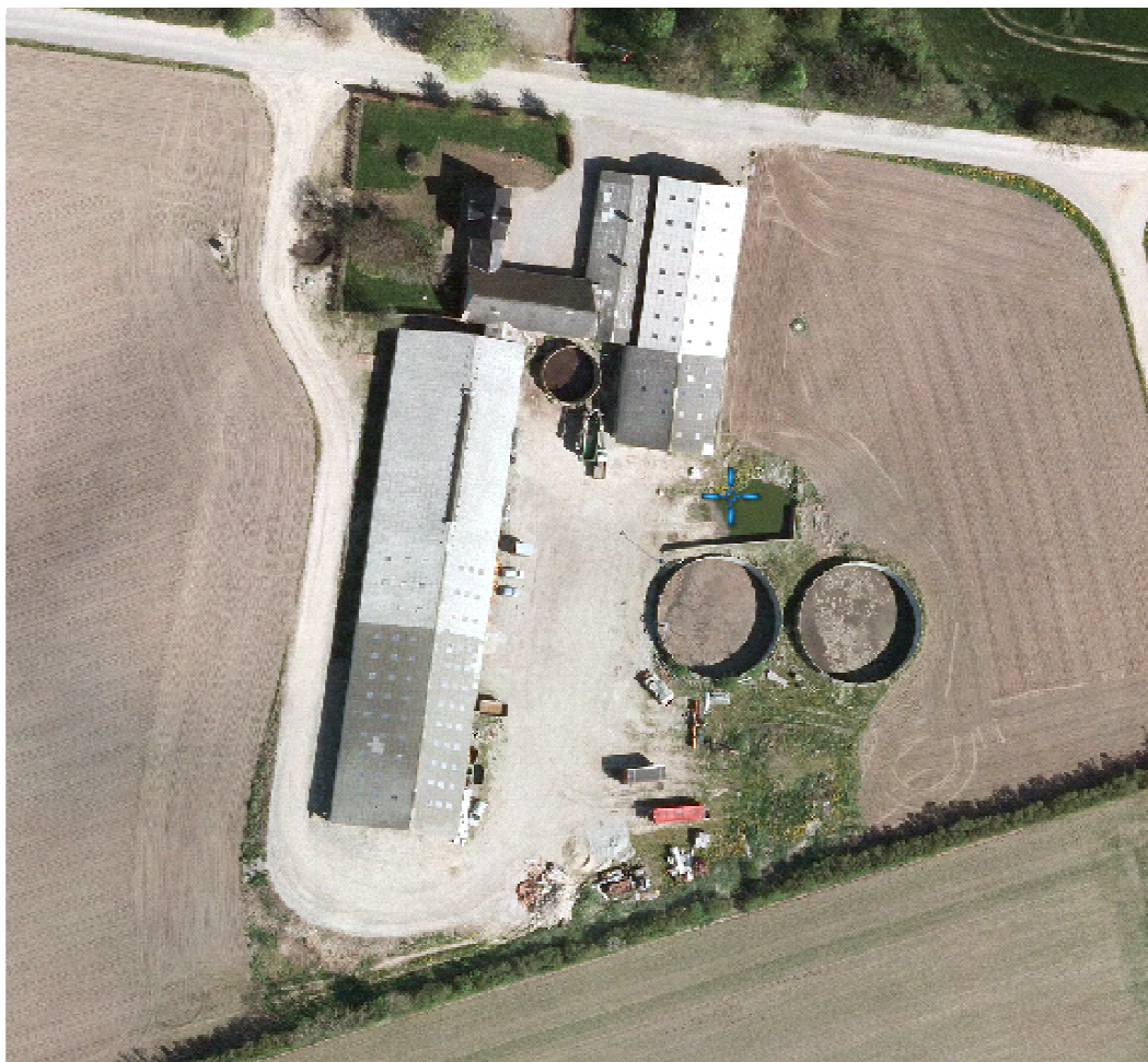
Oversigt over bygningernes og gyllebeholdernes placering på Koledhusvej 2.
