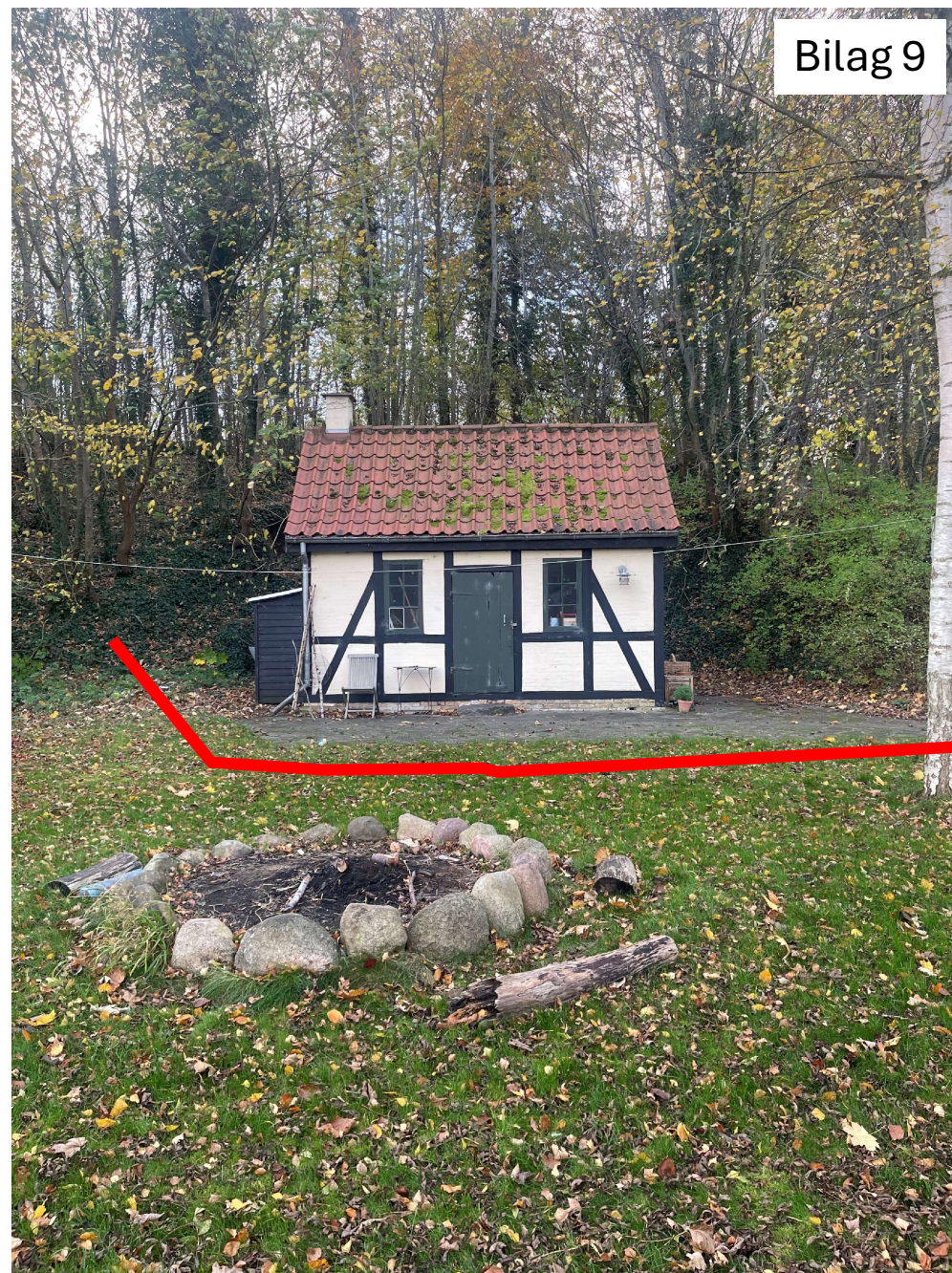
Diget sluttet i bakken bag udhuset hvor terrænet stiger kraftigt
