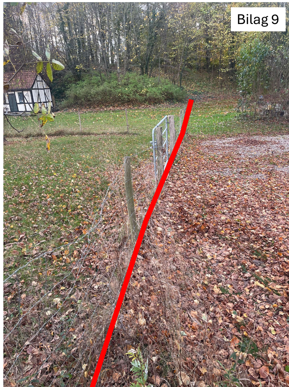
Diget følger overgangen mellem gårdsplads og græsplæne og sluttet af i bakken på modsatte side. Denne placering af diget, tæt på huset, er lavet da diget her kan være lavest muligt samt mest mulig beskytte for evt. "bølger"
