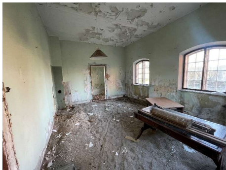
Bygningen indvendig mod vest
