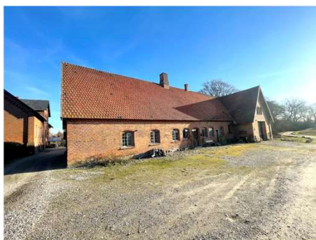
Bygningen mod syd
