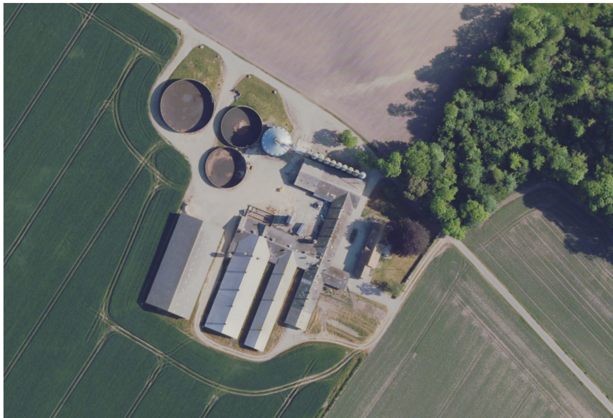
De 3 gyllebeholdere på adressen Alkeshavevej 3, 5853 Ørbæk
