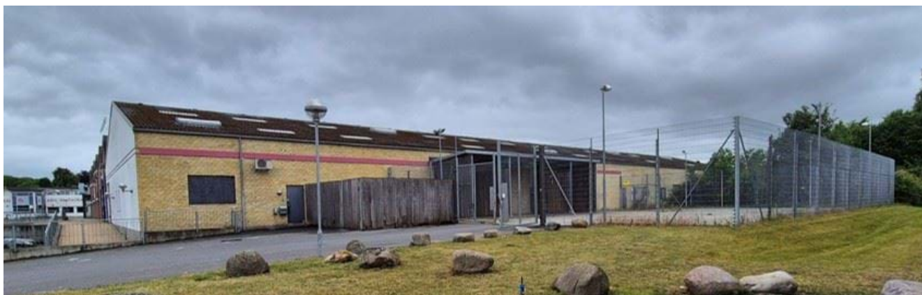
Eksisterende facade nord af Frisengårdsvej 11-13.
