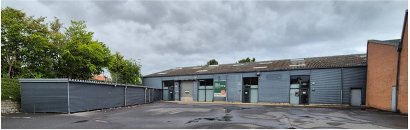
Eksisterende facade mod syd af Frisengårdsvej 13 samt cykelskur i skel mod Hyrdegyden.
