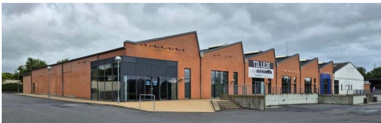
Eksisterende facade mod vest og syd af Frisengårdsvej 7-11.
