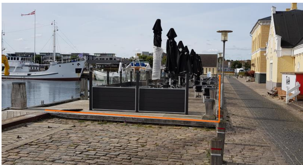
Figur 6-21 Placering af ny azobehammer på strækning Cc-Dd
