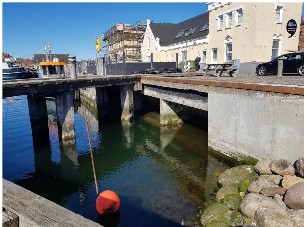
Figur 3-3 Voldgravens udløb i havnebassinet (til højre). I bygværket under Havnegade findes i dag en passiv højvandsklap.
