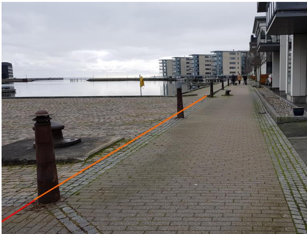
Figur 6-17 Placering af granithammer med betonfundament på strækning X-Y
