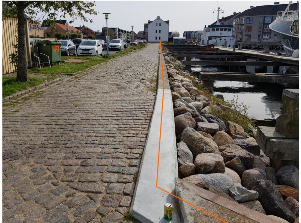
Figur 6-22 Placering af ny betonhammer på strækning Dd-Ee
