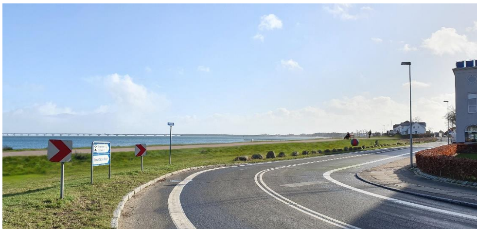
Figur 6-6 Visning af muligt dige foran Hotel Nyborg Strand såfremt der skal sikres til kote 2,5 m.
