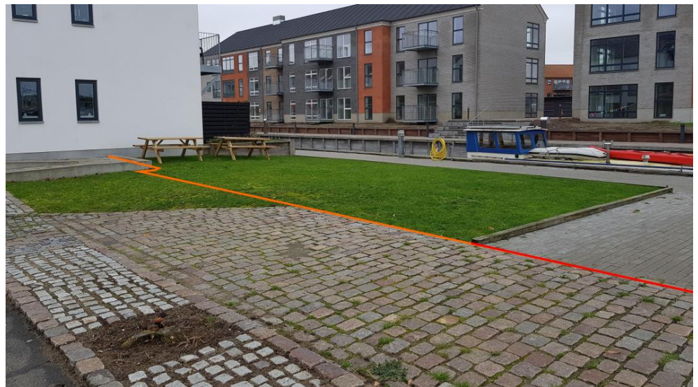
Figur 6-23 Placering af ny betonmur på strækning Ee-Ff
