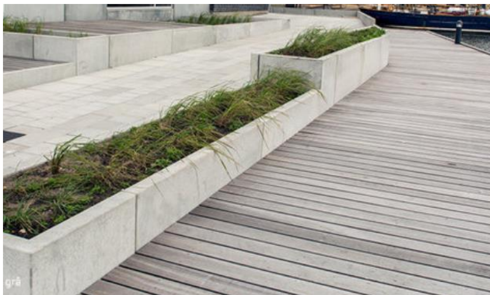
Figur 5-6, Eksempel på anvendelse af L-elementer
