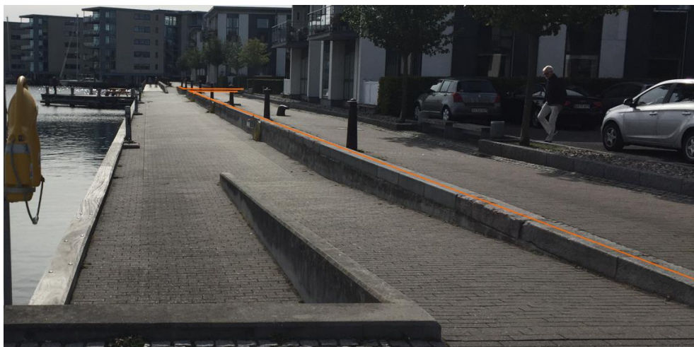
Figur 6-16 Placering af granithammer på strækning V-X
