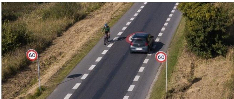
Figur 24 Udformning af en 2 minus 1 vej med et kørespor og brede kantbaner ved 60 km/t.
