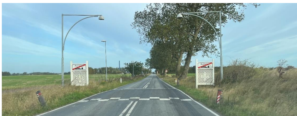
Figur 15 Ved Aunslev er der etableret bump i forbindelse med byzonetavler på Kertemindevej.
