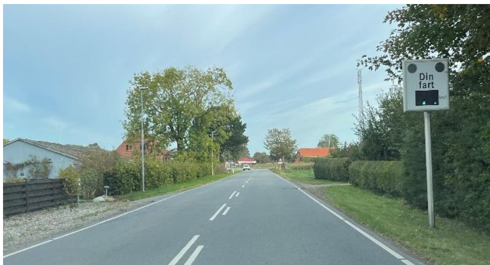
Figur 12 Din fart display på Kertemindevej i Bovenise til påmindelse om den kørte hastighed.
