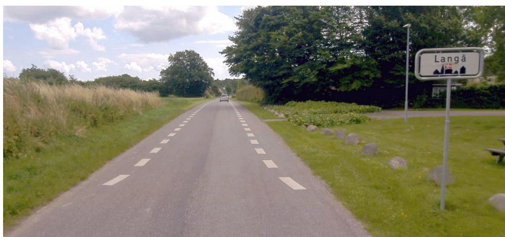
Figur 26 I Langå er der etableret 2 minus 1 vej på Gl. Landevej i 2024. Øverst ses strækningen i 2022 inden ombygning og nederst ses samme lokalitet efter ombygning i 2024.
