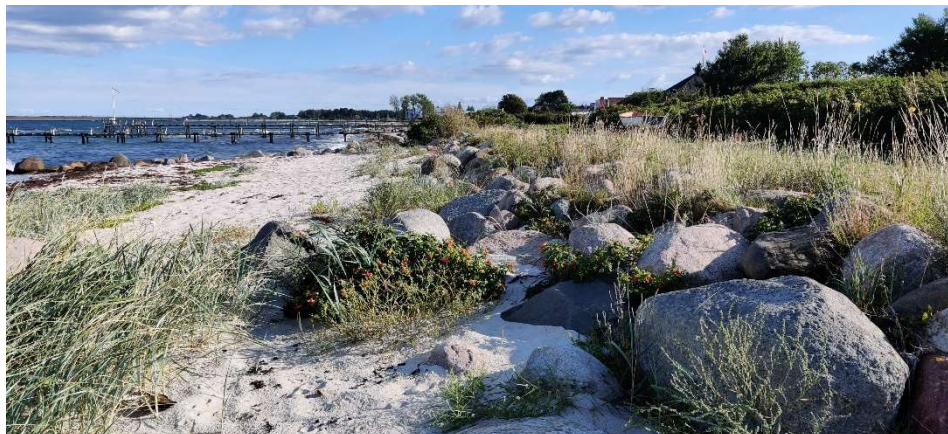
Figur 4.22: Foto af sten, der beskytter skrænten mod erosion. Mellem stenene vokser der marehalm og rynket rose.
