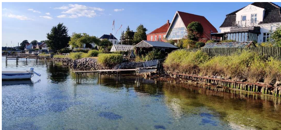
Figur 4.15: Foto af erosionsbeskyttelse foran haver langs Kystvej. Palisadevæggen er i dårlig stand
