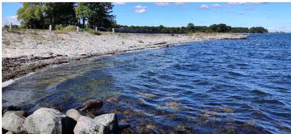
Figur 4.65: Foto af stenglacis og betonmur.
