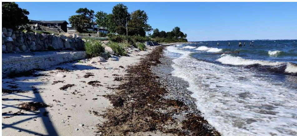
Figur 4.43: Skråningsbeskyttelse foran bebyggelse.
