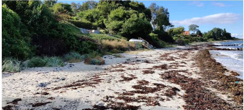
Figur 4.31: Foto af skråningen med tæt bevoksning. Høfderne er flere steder i dårlig stand.
