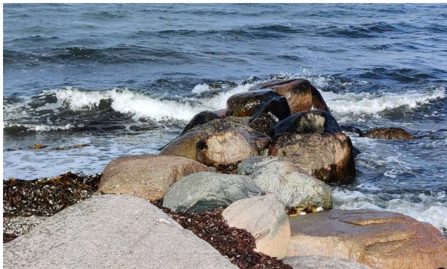
Figur 4.23: Foto af stabil opbygget høfde.
