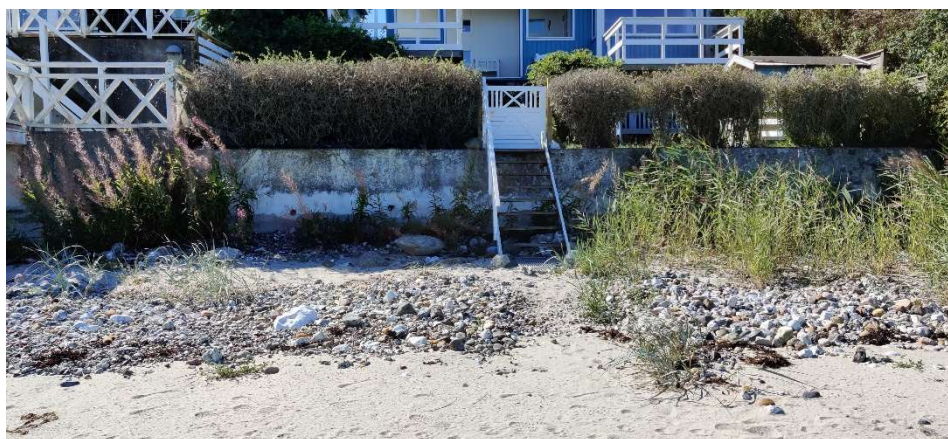
Figur 3.3: Eksempel på betonmur. Terrænet foran og bagved muren er i forskellig højde. Fotoet er taget under kystinspektionen d 1/9-2020.
