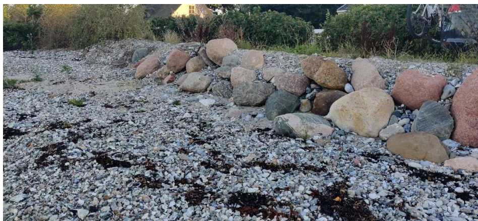
Figur 4.8: Foto af skråningsbeskyttelse, der beskytter Kystvejen mod erosion.
