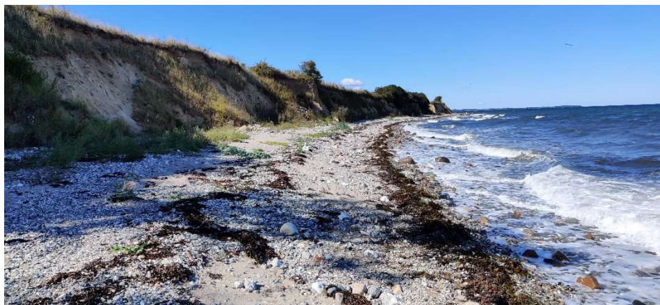
Figur 4.41: Foto af ubeskyttet skrænt.
